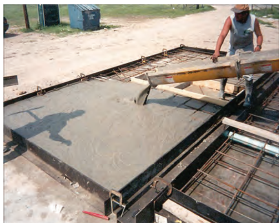
ЛИТЬЁ ЛЁГКИХ ПЕНОБЕТОННЫХ ПАНЕЛЕЙ LITEBUILT®
