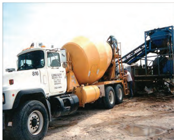
LITEBUILT® ПЕНА ВВОДИТСЯ В АВТОБЕТОНОСМЕСИТЕЛЬ
