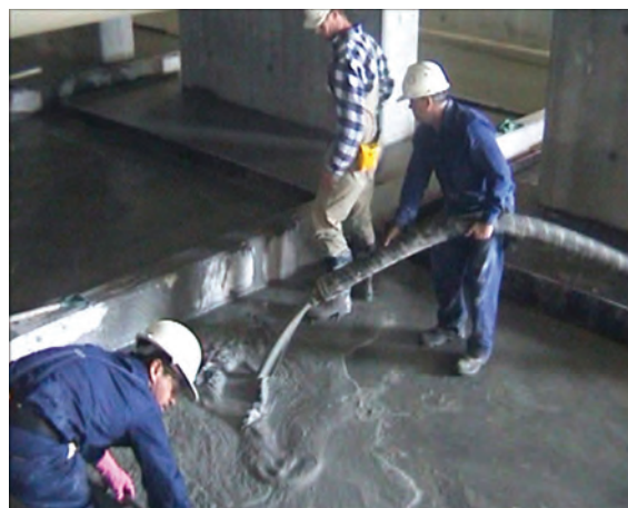
РАЗРАВНИВАНИЕ ПЕРЕКРЫТИЯ
